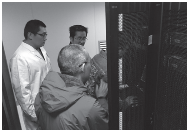
系统切换当天孙磊坚守在机房（左一为孙磊）
